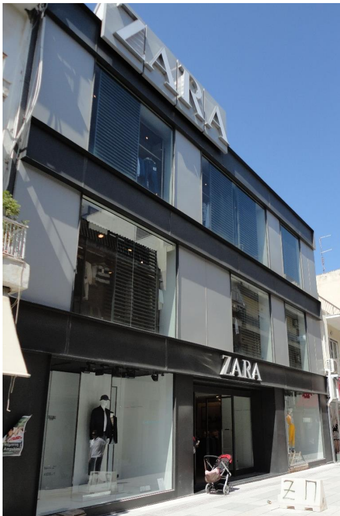
Εικόνα 4.1: Κατάστημα ZARA, στην Χαλκίδα (Αβάντων 39), Νοτιοδυτική όψη του κτηρίου
