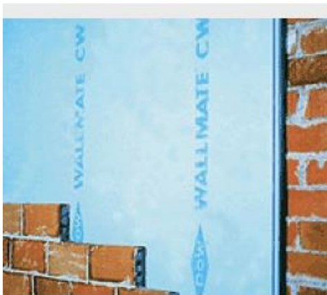
Εικόνα 5.2: Θερμομόνωση εξωτερικής τοιχοποιίας
